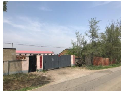
遗址北侧厂房
